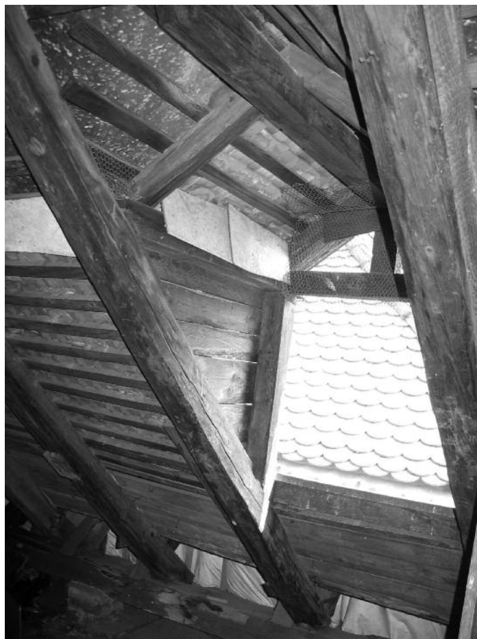
Slika 30: Nastrešnica na vzhodni strešini
