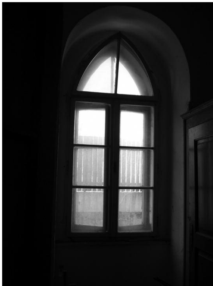
Slika 18: Šilasto okno na zahodni strani stavbe, ki osvetljuje sanitarije
