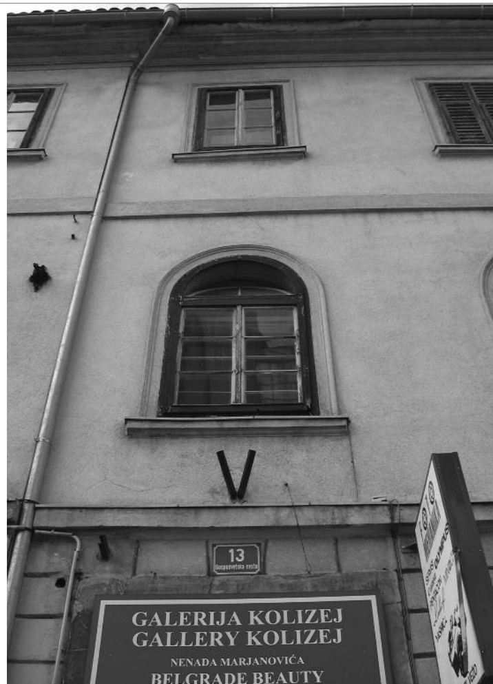
Slika 4: Osrednja os severnega pročelja
