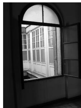
Slika 22: Pogled skozi okno na hodniku v svetlobnik
