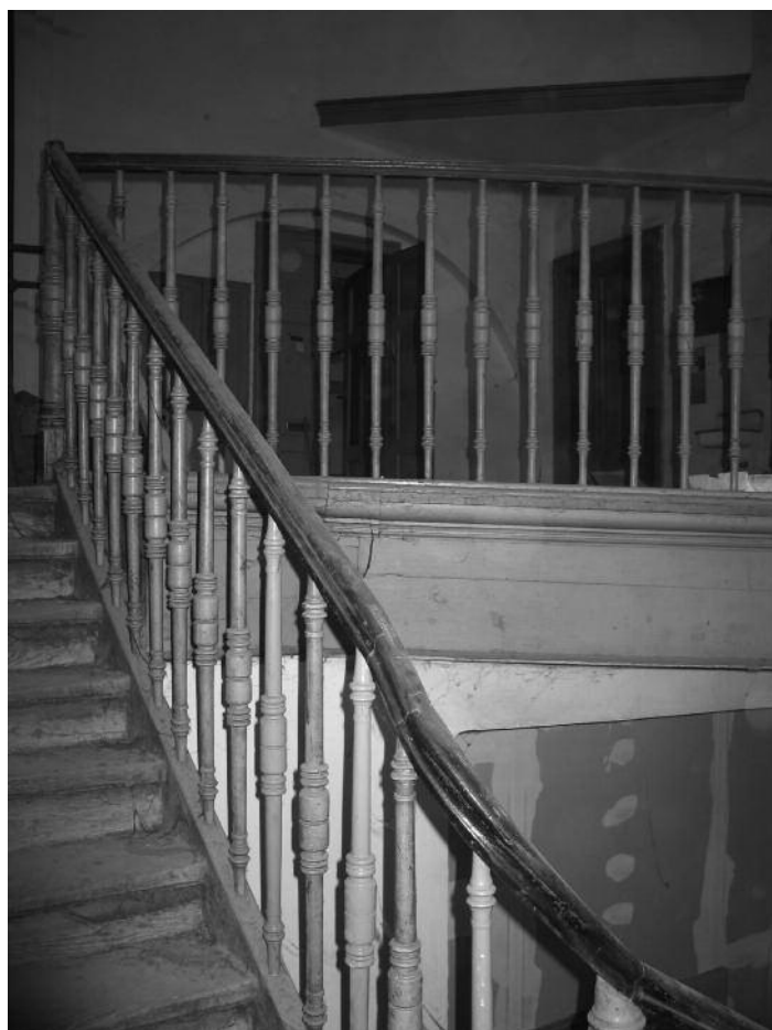
Slika 23: Dostop do severne dvorane po zahodni rami stopnišča
