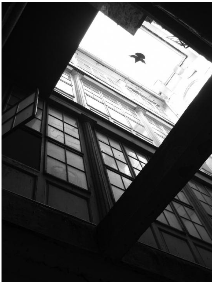
Slika 11: Pogled po svetlobniku od spodaj navzgor
