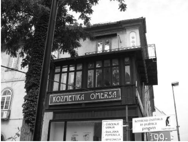
Slika 15: Lesena veranda na vzhodnem pročelju
