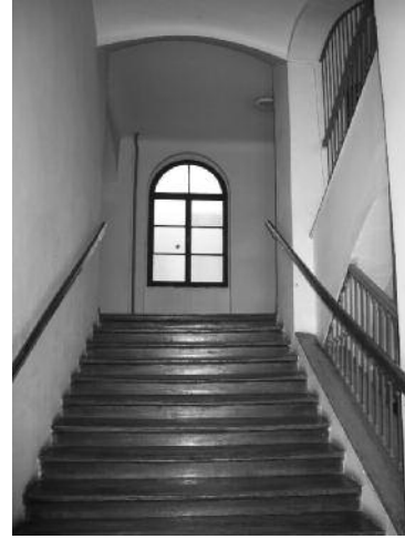
Slika 2: Severni del stavbe – severna rama dvoramnega stopnišča med kletnim podestom in pritličjem
