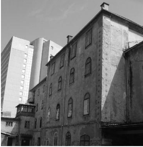
Slika 17: Zahodno pročelje – osrednji rizalit z vogalnima lizenama
