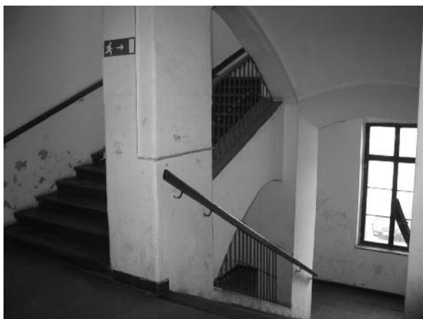
Slika 9: Dvoramno leseno stopnišče z zidanimi slopi
