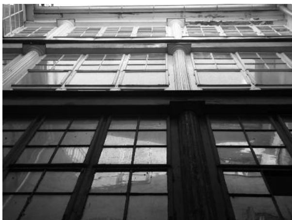
Slika 9: Pogled po svetlobniku od spodaj navzgor
