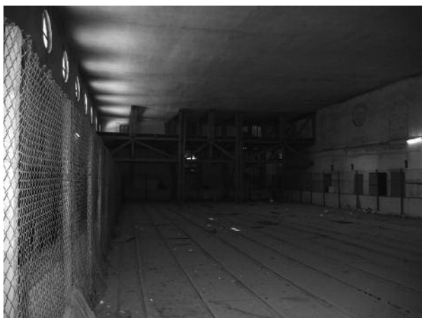
Slika 27: Nekdaj dvoetažna dvorana, pregrajena v višini stropa pritličja
