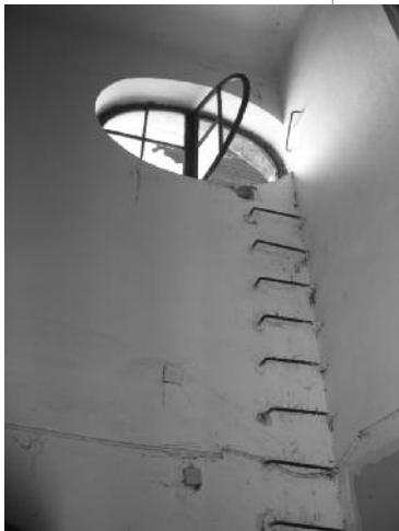
Slika 25: Dostop do ovalnega okna na vzhodni steni dvorane
