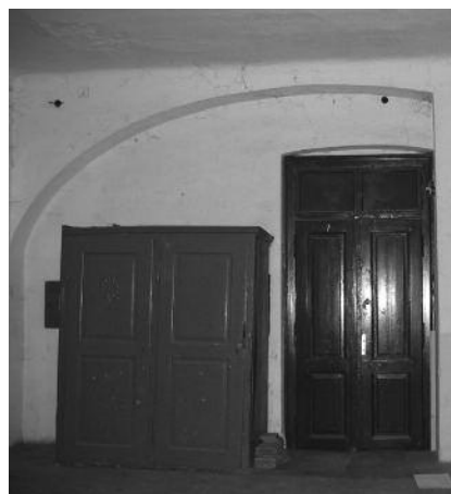
Slika 16: Vrata v stanovanje in lesena omara v stenski niši na zahodni steni hodnika
