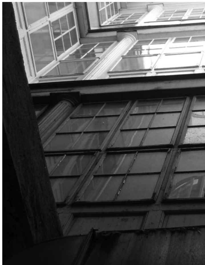
Slika 12: Pogled po svetlobniku od spodaj navzgor
