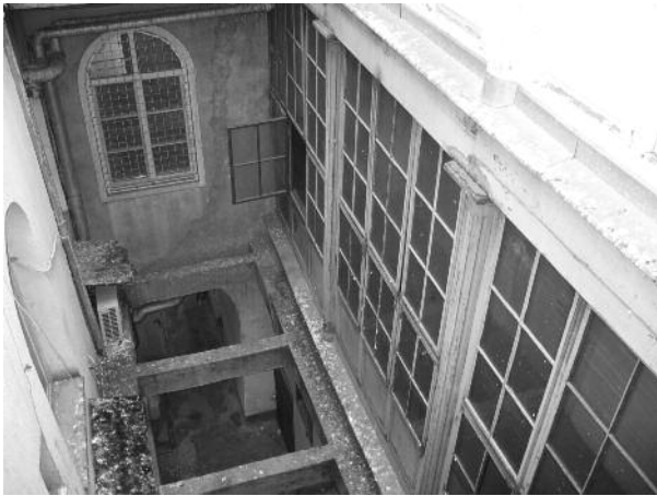
Slika 3: Severozahodni kot svetlobnika
