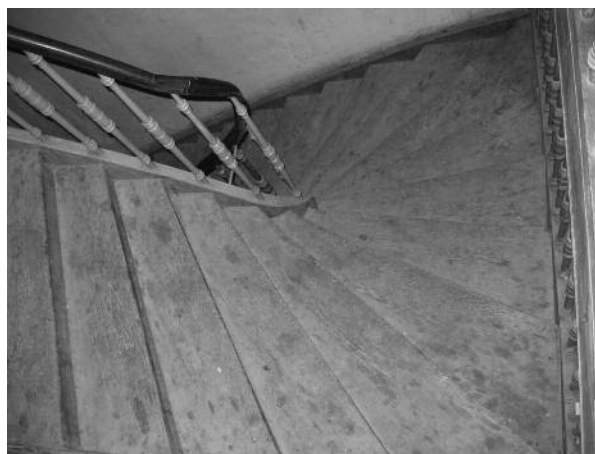
Slika 46: Stopnice – pogled od zgoraj
