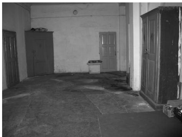
Slika 45: Severni del stavbe – vhod v sobo
