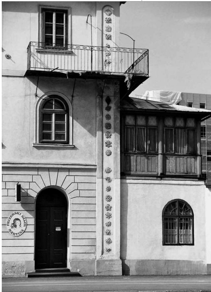
Slika 3: Zahodni del severnega pročelja – vogalna lizena z nizom rozet in lesena veranda
