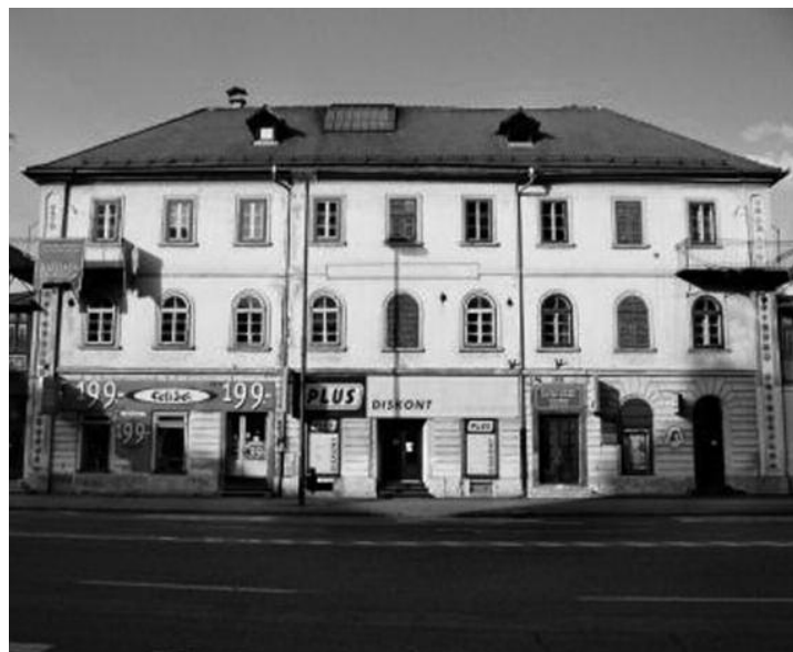
Slika 2: Severno pročelje ob Gosposvetski cesti
