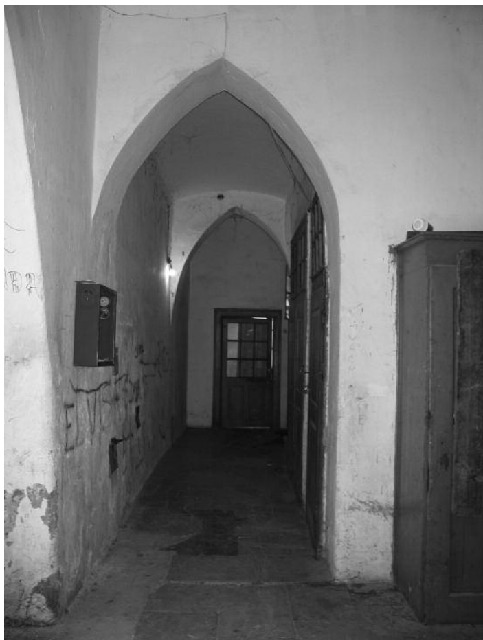
Slika 17: Zahodna stran osrednjega hodnika s šilastoločnimi prehodi
