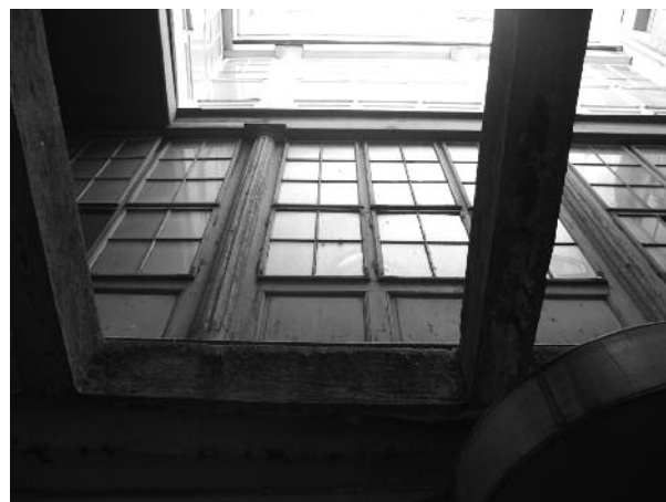
Slika 10: Pogled po svetlobniku od spodaj navzgor
