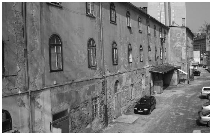
Slika 8: Vzhodno pročelje – pogled proti hotelu Lev
