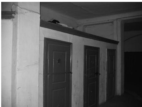
Slika 15: Shrambe ob južni steni hodnika na severni strani dvorane z lesenimi enokrilnimi vrati
