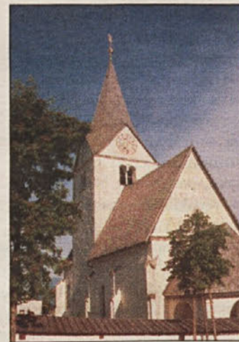
Cerkev sv. Jakoba v Bilčovsu je značilna koroška cerkev s kornim zvonikom med oltarnim prostorom in ladjo.
