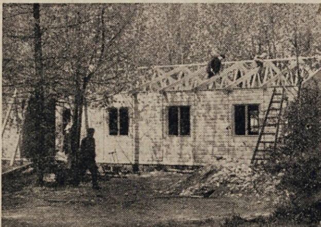
Montaža provizorija pred poslopjem predilnice
