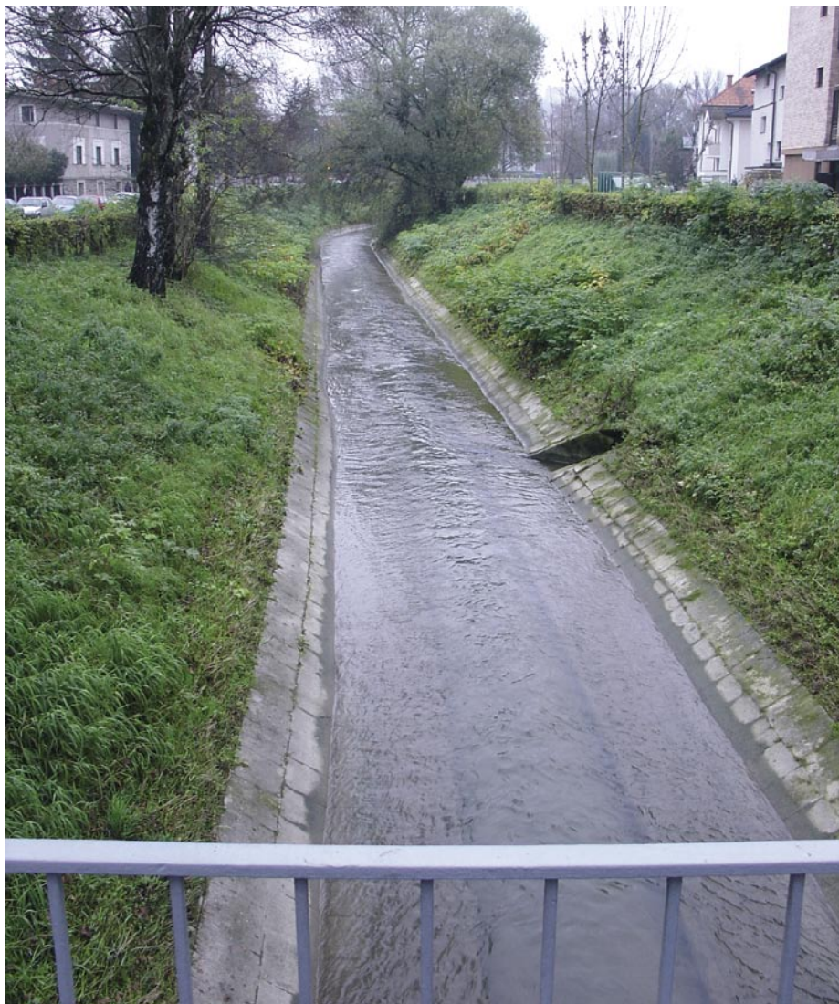
Slika 8 • Izpust iz razbremenilnika v odvodnik
