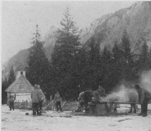
Prostovoljno delo v Tamarju: Smoljenje vodovodnih cevi
