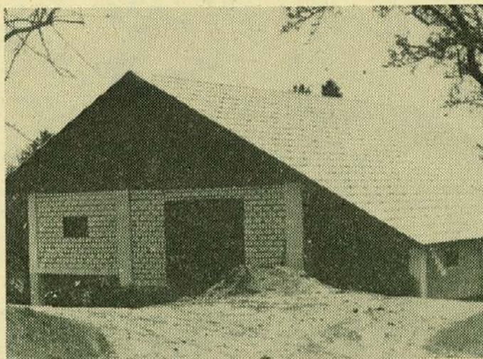
Vedno več takih hlevov imamo — žal še vedno brez strelovodov
