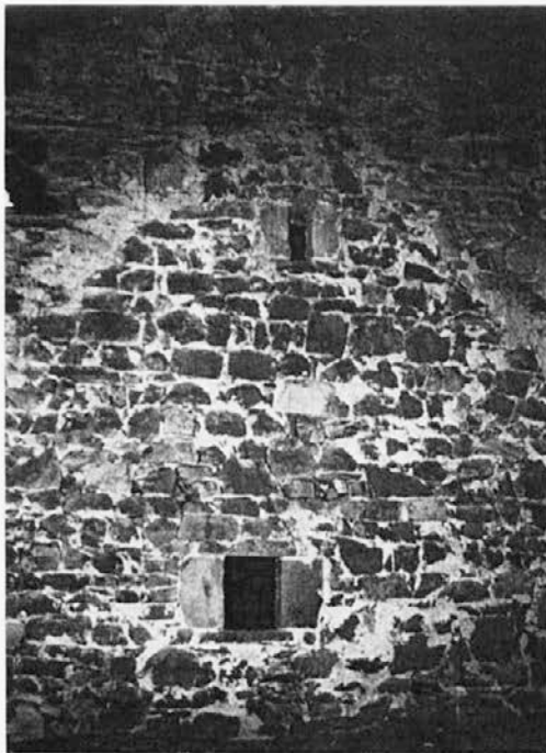
Sl. 3: Zgornji del vzhodnega pročelja, danes pod streho vzhodnega prizidka. Spodaj je okno, zgoraj dimna lina; dobro je viden stik nadzidave in prvotnega zatrepa. – Foto Božidar Premrl.
