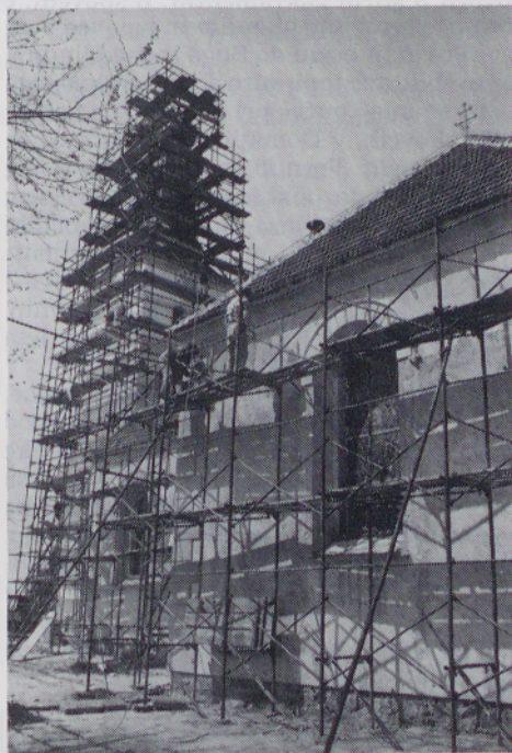
Župnijska cerkev med obnovo
