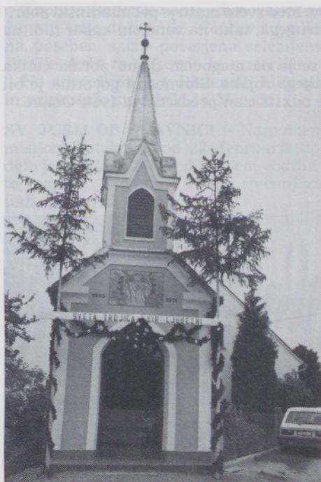
Obnovljena nuskovska kapela
