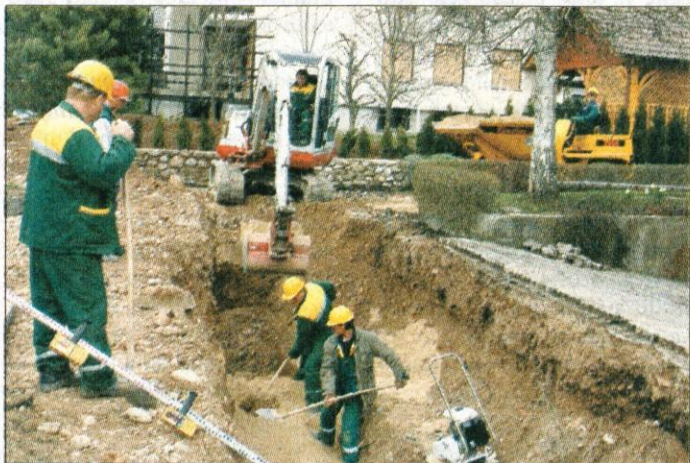
Prebivalci Kalinškove na Primskovem zadovoljni z izvajalci gradnje kanalizacije. - Foto: Tina Dokl
