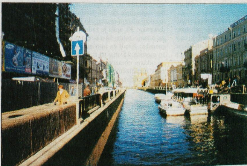
Kanal Gribojdiva s stavbami v remontu - celo mesto se pripravlja na 300-letnico.
