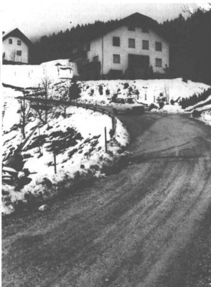
BELE VODE — Posodobitev cest
