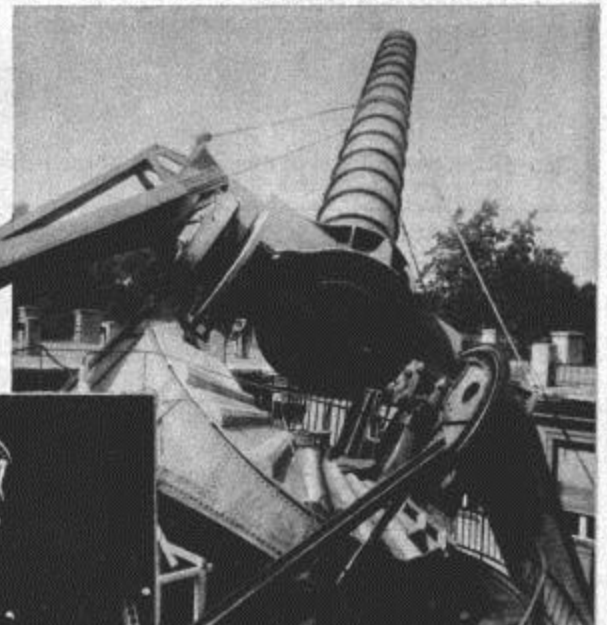
Der 21-Meter-Reflektor der Treptower Sternwarte (Berlin). Das Objektiv des in seinen Ausmaßen gewaltigen Rohres hat einen Durchmesser von 68 Zentimeter
