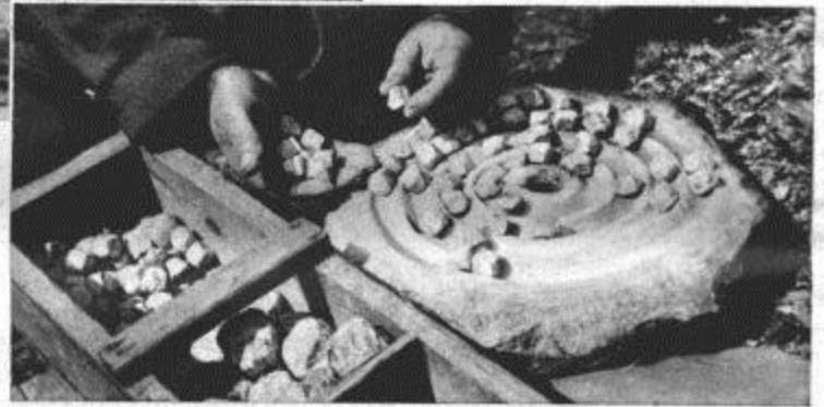
Der Kugelmüller hat eine der Mühlen aufgedeckt. Der obere Buchenholzdeckel mit den Turbinenschaufeln auf der Oberseite ist zurückgeschoben, so daß die Kugeln in den Rillen des Steinblocks zur Prüfung frei liegen
