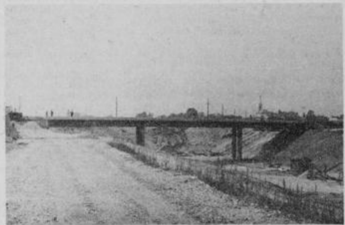
Novi most pri Markovcih. Dela so v zaključni fazi.
