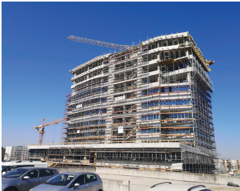
Slika 4. Izvedena streha nad 10. nadstropjem, april 2022.
