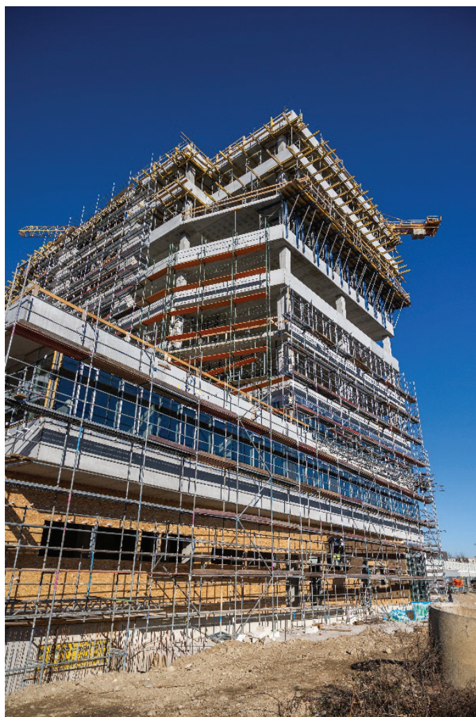
Slika 7. Konstrukcija terja montažo izjemno zahtevnih odrov in podpornih opažnih elementov, februar 2022.
