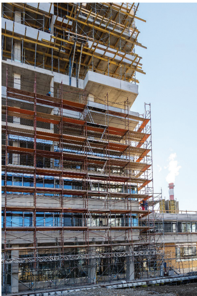
Slika 6. Prikaz razgibane armiranobetonske konstrukcije, februar 2022.
