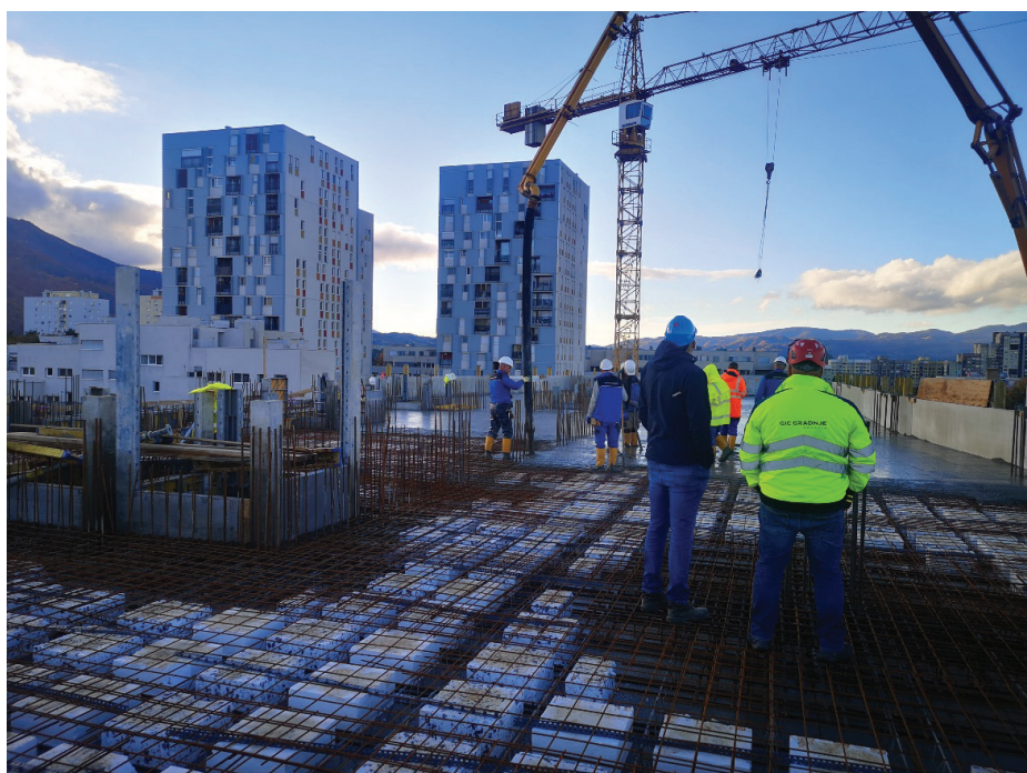
Slika 3. Delno montažna izvedba medetažne plošče (sistem Omnia), november 2021.
