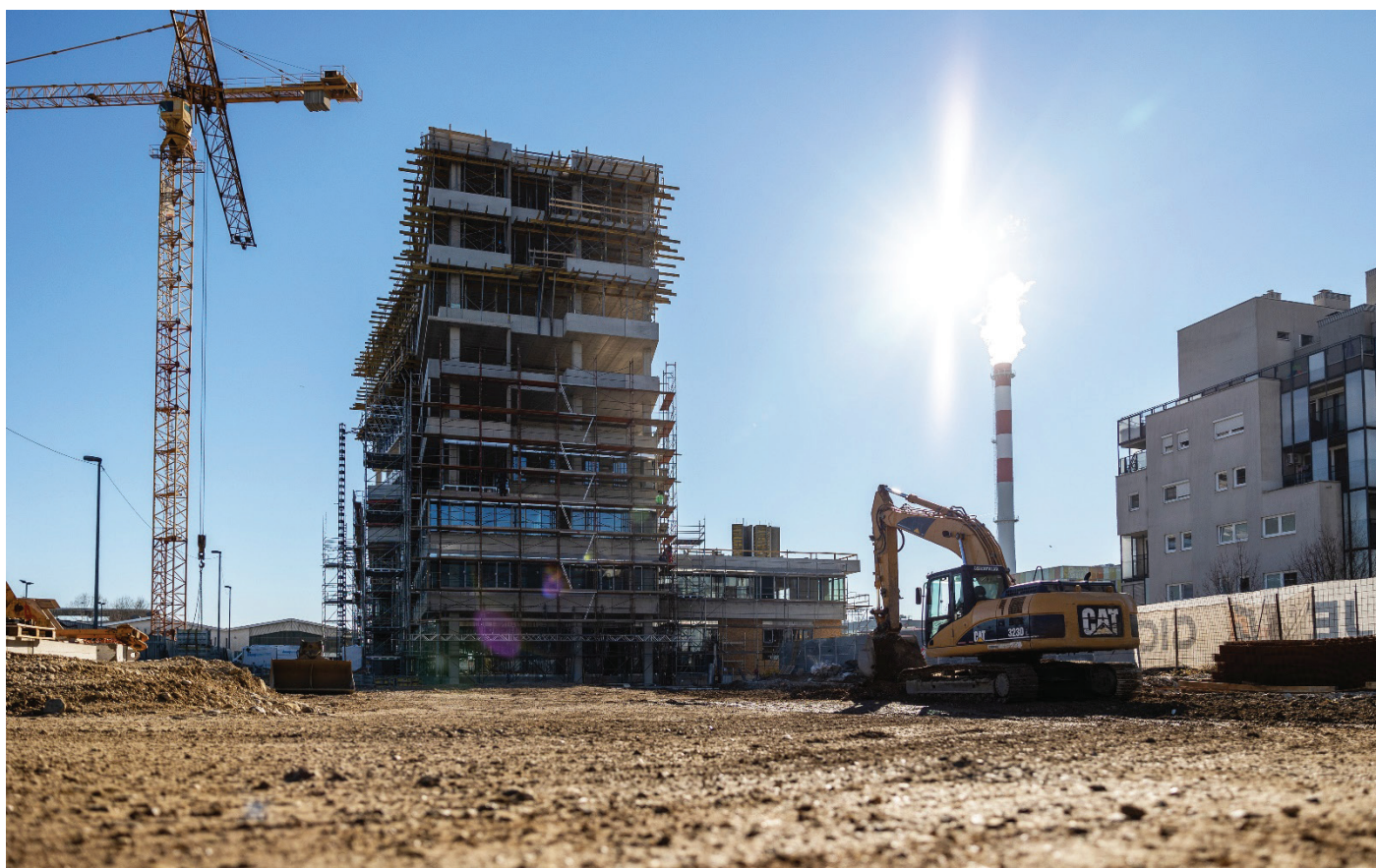
Slika 1. Objekt v fazi izvedbe zadnjih grobih gradbenih del na stolpničnem delu stavbe, februar 2022.
