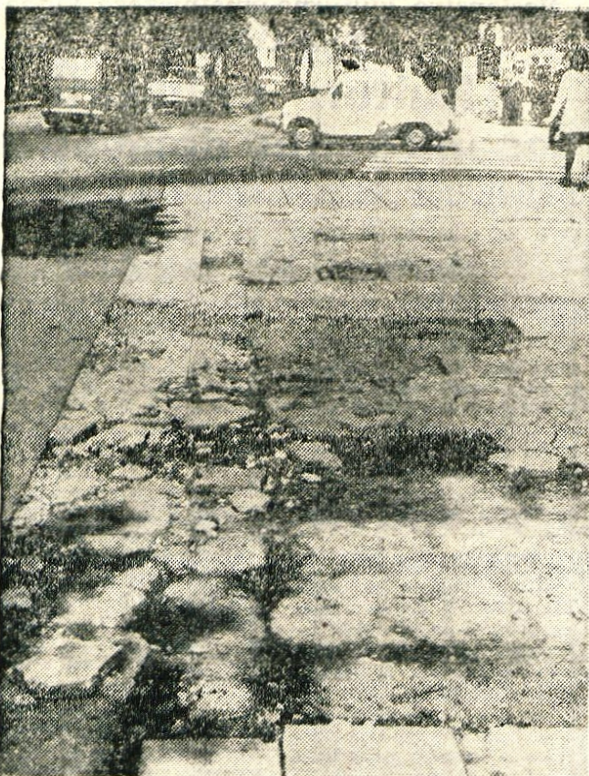
Sneg, mraz in dež so v nekaj letih takole razrahljali del ploščadi na Trgu revolucije v Kranju. Kako jo bodo uredili, je bilo postavljeno vprašanje tudi na eni od sej kranjske občinske skupščine. Odbornik je takrat predlagal, naj ne bi znova položili gladke plošče, ki so pozimi že marsikomu vzele tla pod nogami. Zvedeli smo, da bodo ploščad urejali skupaj s ploščadjo pred blagovnico Globus. Namesto plošč bodo položili asfalt. — A. Z. — Foto: F. Perdan
