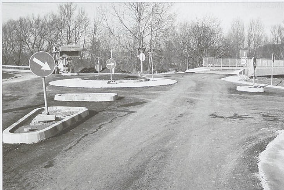
Most v Hajdošah je obnovljen, z izgradnjo krožišča pred mostom, pa so se tudi zaključila dela na tem več let trajajočem projektu.
