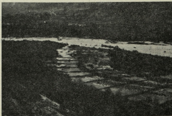
Sl. 9. Urejevalna dela na Soči pri Čezsoči (1958). Vegetativne prečne zgradbe bodo pospešile kolmaciju starega rokava
