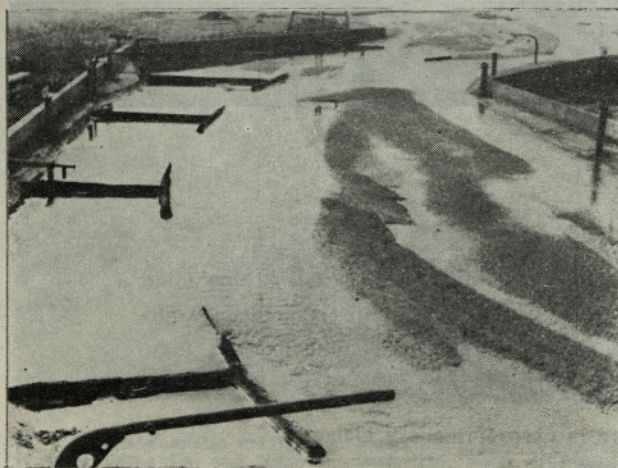
Sl. 1. Model Save na odseku med Črnučami in Sv. Jakobom. M 1 : 75 : 30, dolžina odseka 2,5 km
