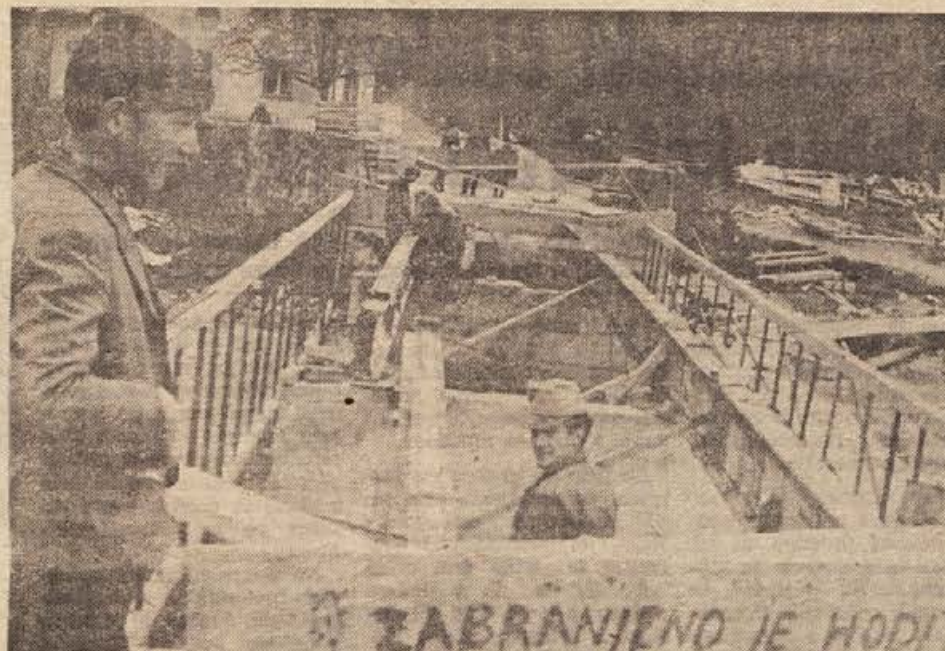
Novi most med Dolenjo vasjo in Prigorico bo predvidoma dograjen za 29. november. Upajmo, da del ne bo zavrla slabo vreme. Gradi ga SGP ZIDAR iz Kočevja. Novi most bo zelo trden. (Foto: Prime)
