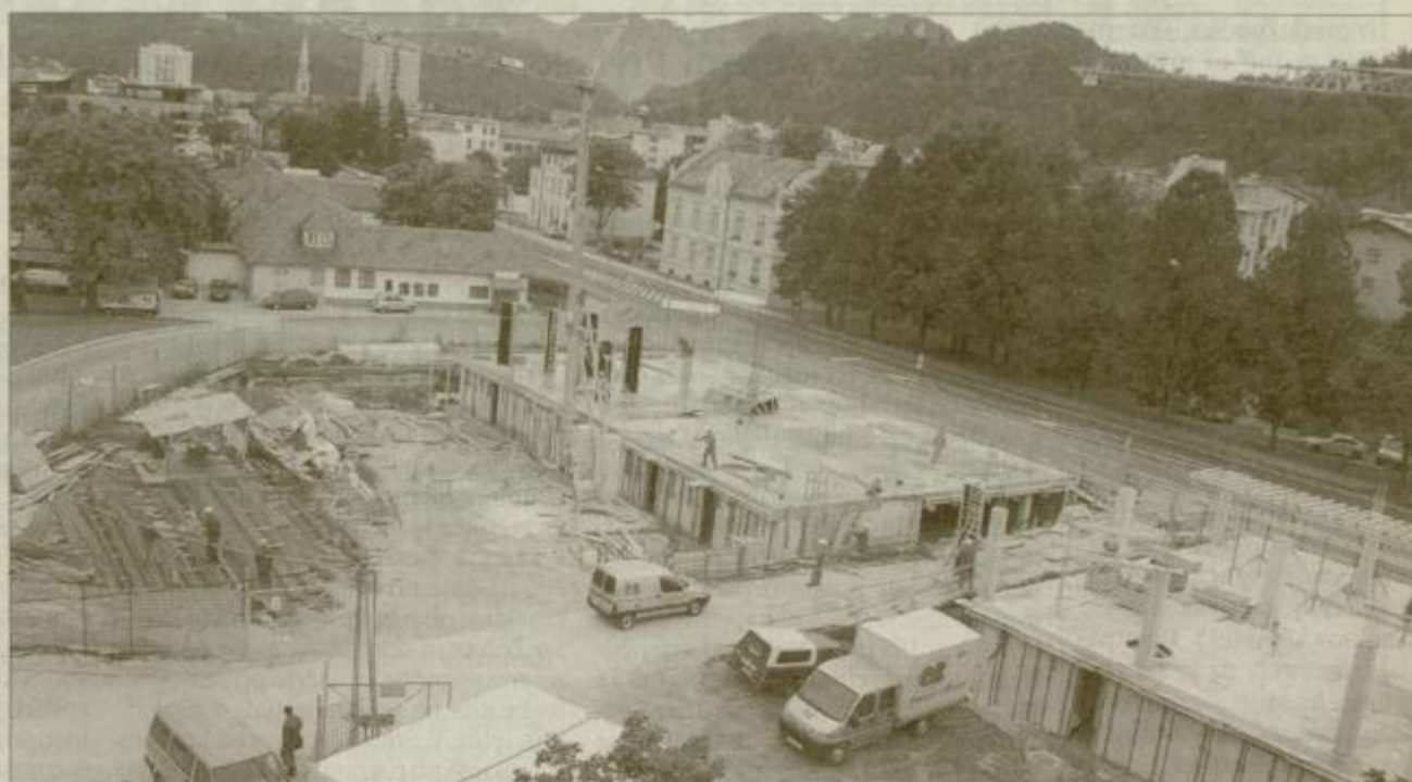
Gradbena dela Na Zelenici so se začela sredi avgusta, oba objekta pa bosta pod streho v začetku oktobra. Gradbeništvo Božičnik gradi po veljavnem zazidalnem načrtu, v primeru, da bodo mestni svetniki potrdili predlagane spremembe, pa bo v obeh objektih več stanovanj in manj poslovnih prostorov.
