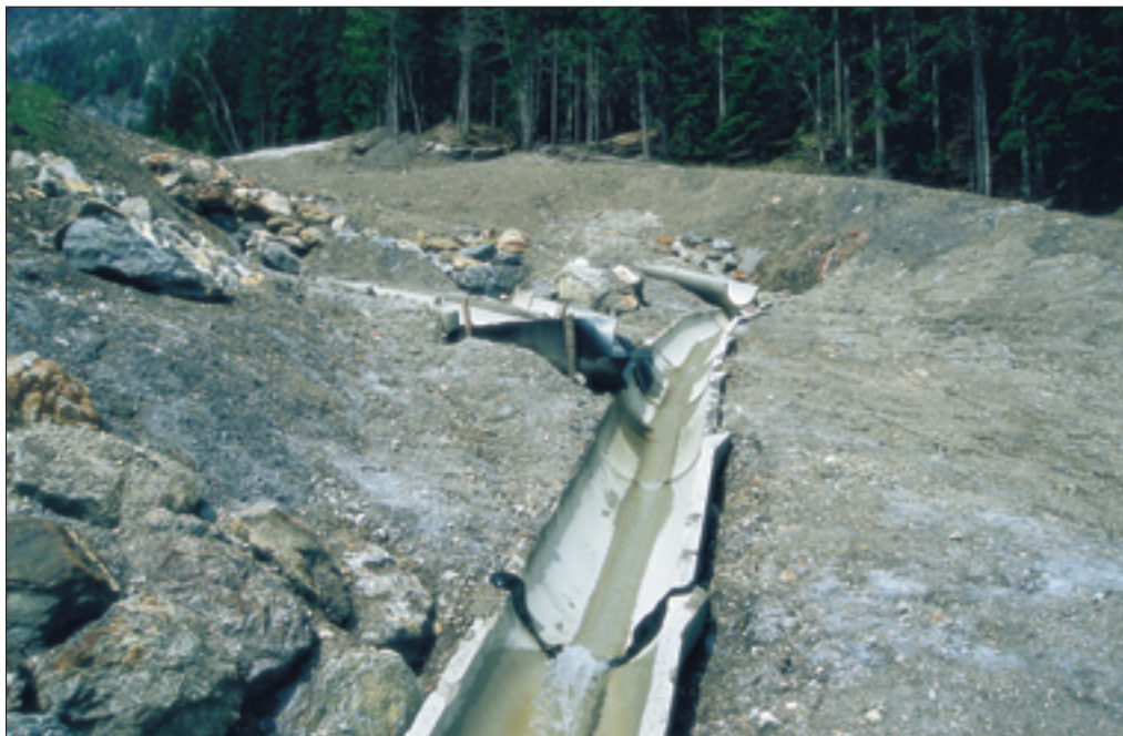
Slika 56: Drenaža Maccesnikovega plazu.
