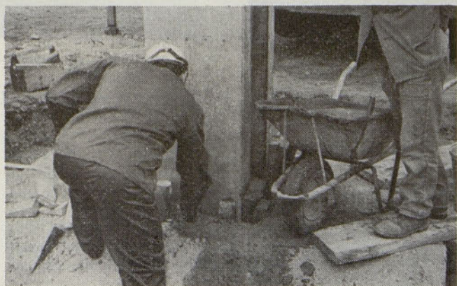
Otvoritev gradbišča nove livarne s postavljanjem prvega stebra
