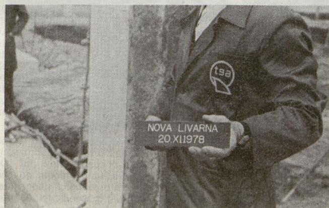
Začetek gradnje nove livarne
