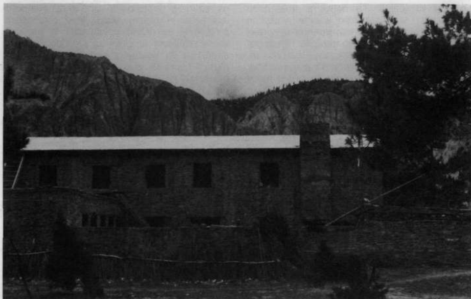
Šola za gorske vodnike v Manangu: takšna je zdaj streha, nekoliko nagnjena in pokrita z valovito pločevino
