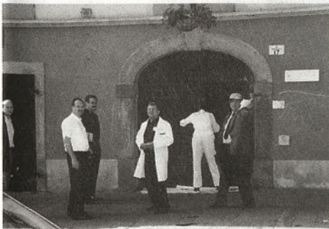
Obnova vhodnih vrat v Prešernovi 17, 10. maja. Foto Langerholc
