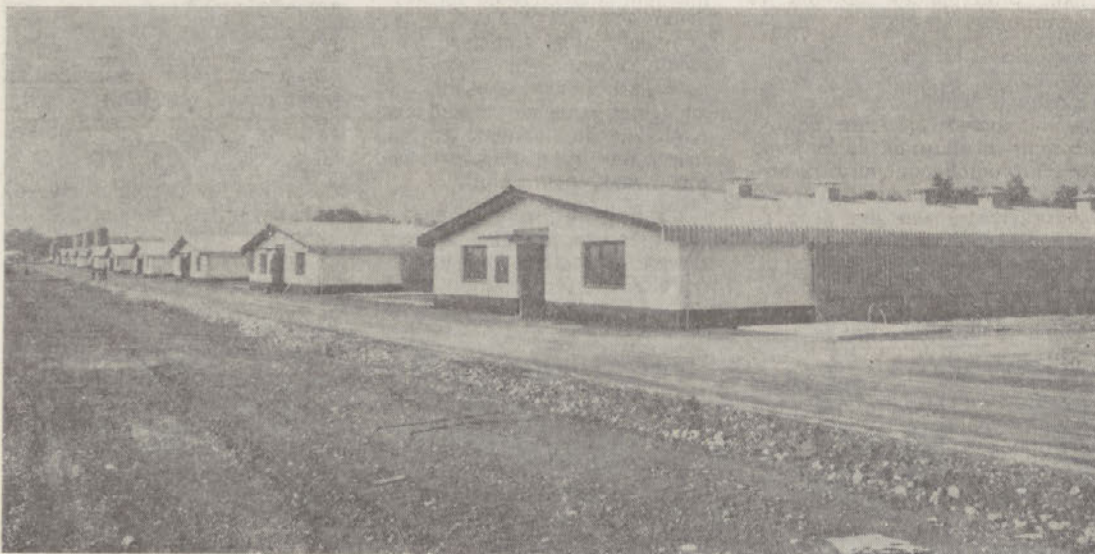
Pogled na devet novozgrajenih objektov
