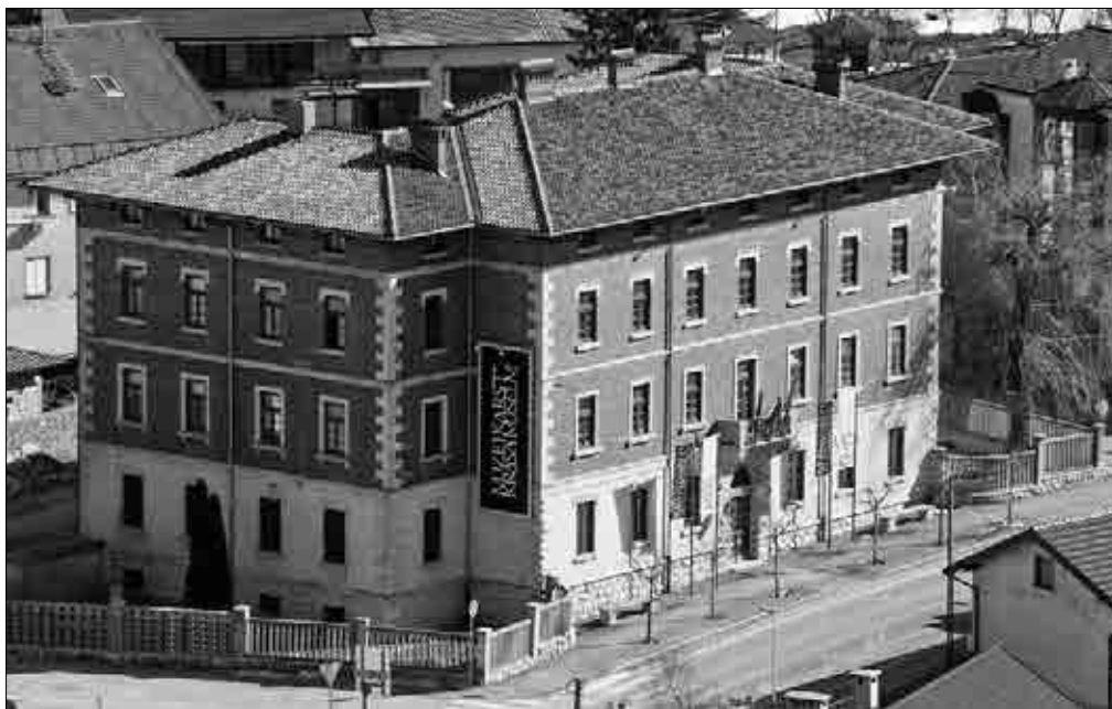
Stavba Notranjskega muzeja Postojna na Kolodvorski cesti v Postojni (foto: Tomaž Penko).
