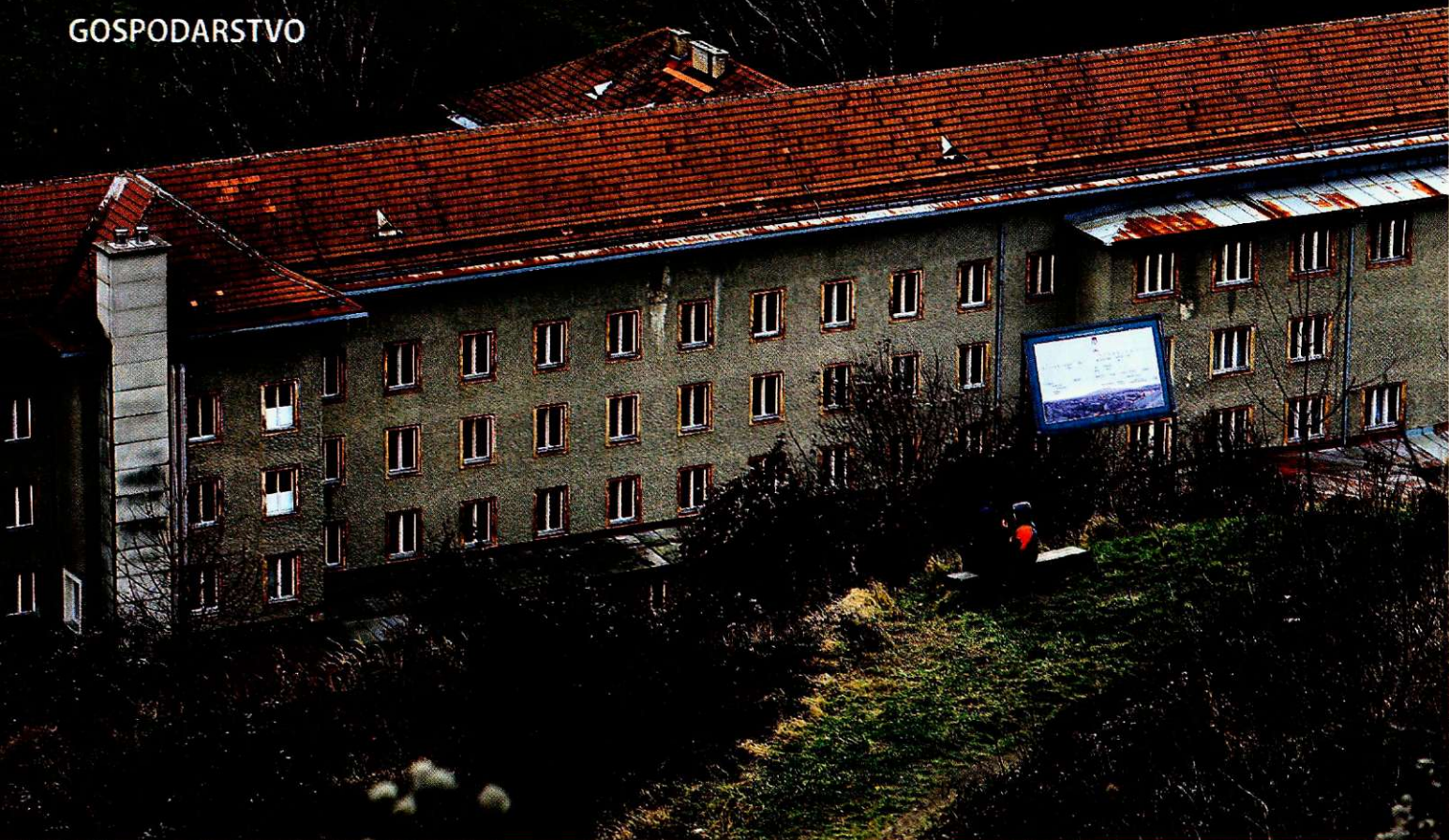
Stavba na Vrbanski 30 v Mariboru
