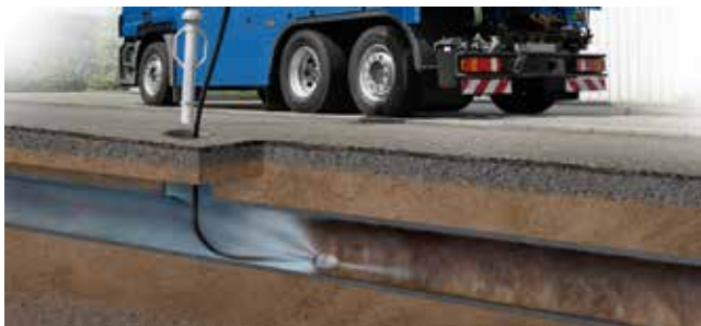
Slika 6 : Učinkovito visokotlačno čiščenje cevi in kanalizacije z visokotlačno batno črpalco P3-19
