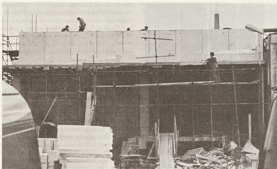
Minili so štirje meseci, ko smo se pomudili pri gradnji prizidka pri grobem razrezu. Zgradba je v končni gradbeni fazi.
