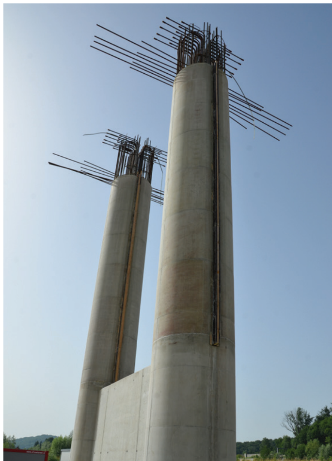
Slika 3. Razdeljeni steber je podpora dveh okvirjev (foto: Ponting, d. o. o.).
