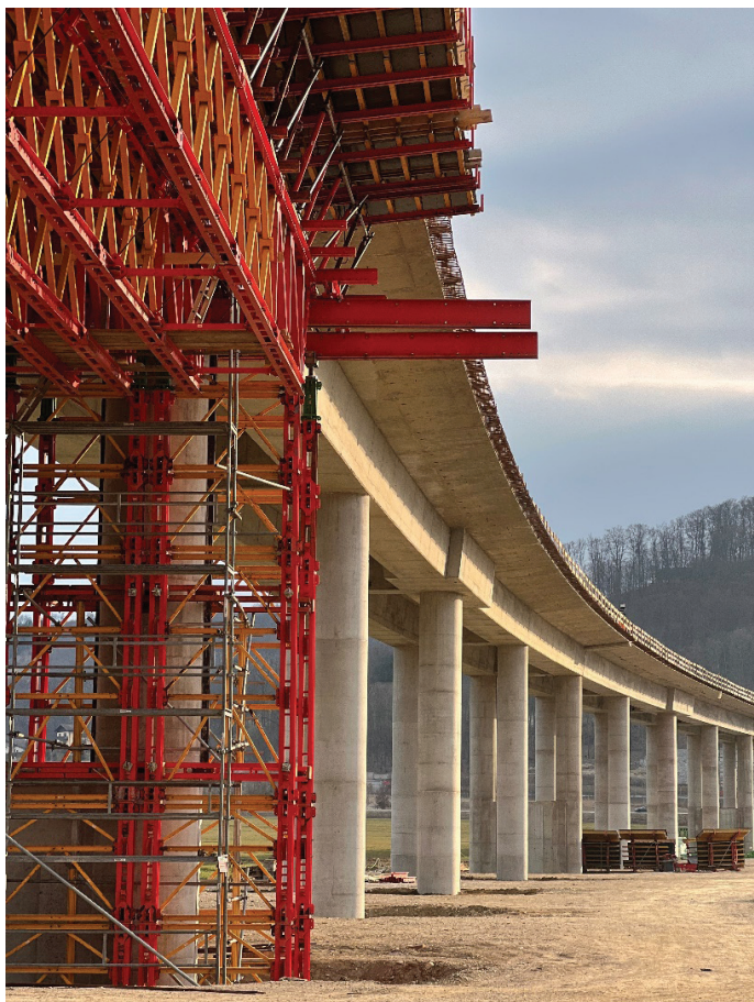
Slika 4. Viadukt z odrom za novi segment (foto: Srečko Prša, Pomgrad, d. d.).
