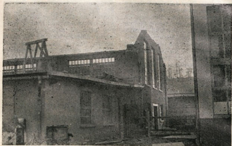
Zdajšnje skladišče drobnega materiala je ostalo brez strehe. Kmalu bo namesto skladišča podaljšek topilnice
