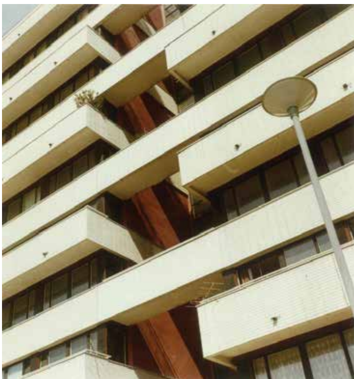
Slika 8. »Rdeče stene« na čelnih straneh vsake lamele stanovanjskega bloka »B-9« (1960–1966) Vir: zasebni arhiv avtorja prispevka
