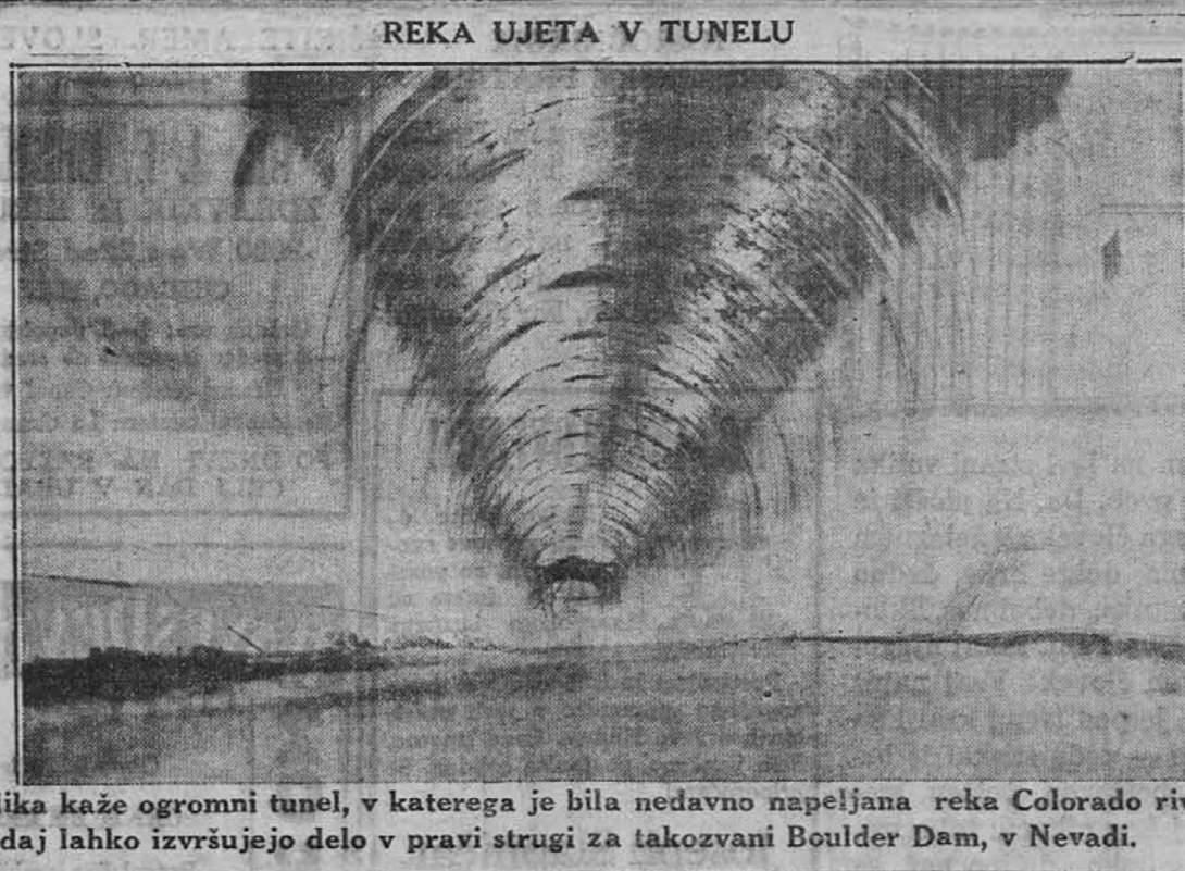
Slika kaže ogromni tunel, v katerega je bila nedavno napeljana reka Colorado river, da tako zdaj lahko izvršujejo delo v pravi strugi za takozvani Boulder Dam, v Nevadi.
