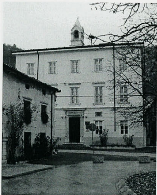
Nekdanji samostanski stavbi
