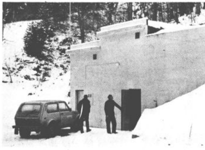
V vodohramu pod Čreto je "prostora" za 120.000 litrov pitne vode, ki jo sem načrpajo iz Pustega polja
