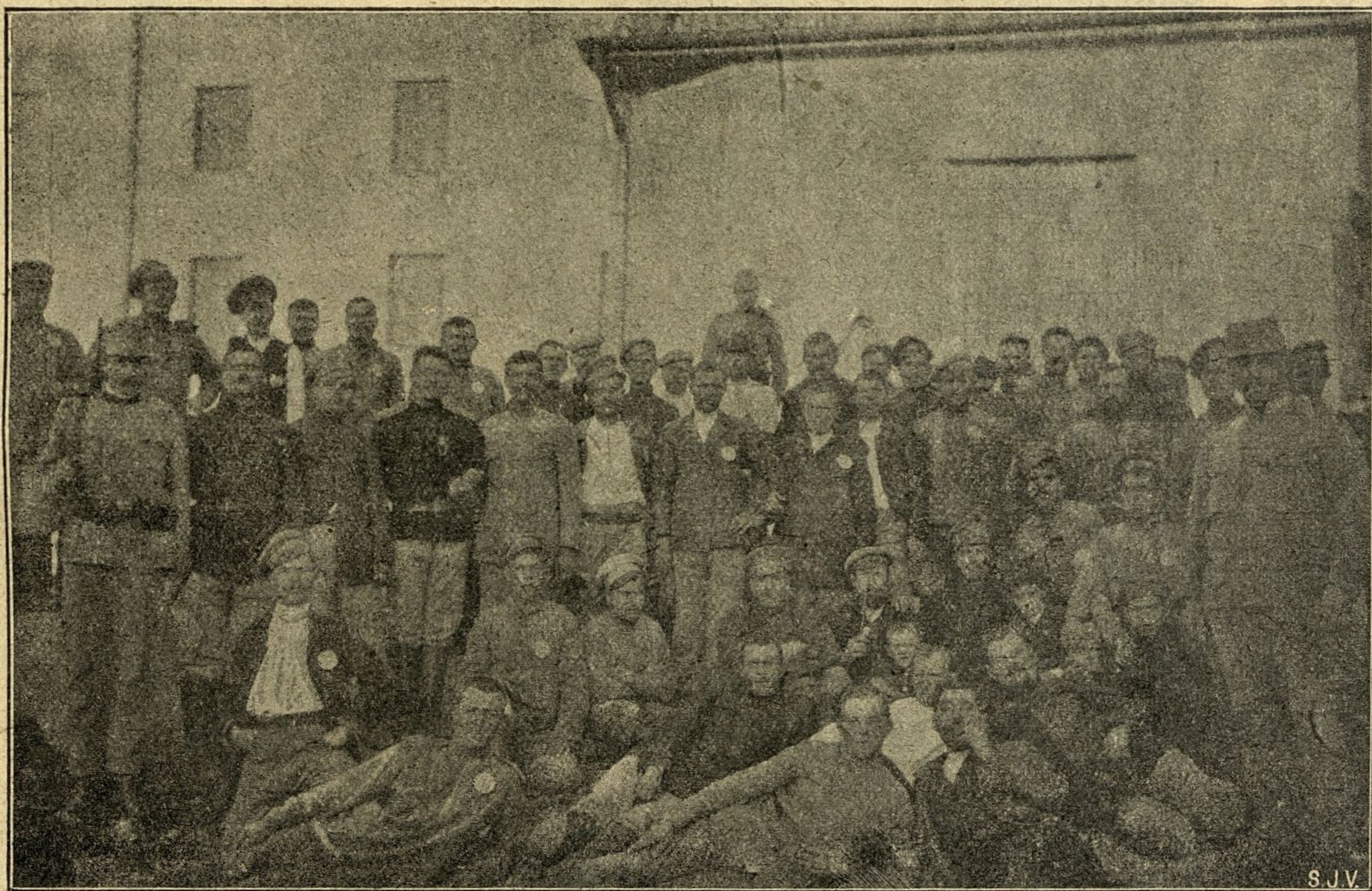
Kriegsgefangene Russen, die für Damm- und Erdarbeiten bei Köchlarn a. d. Donau beschäftigt wurden.
