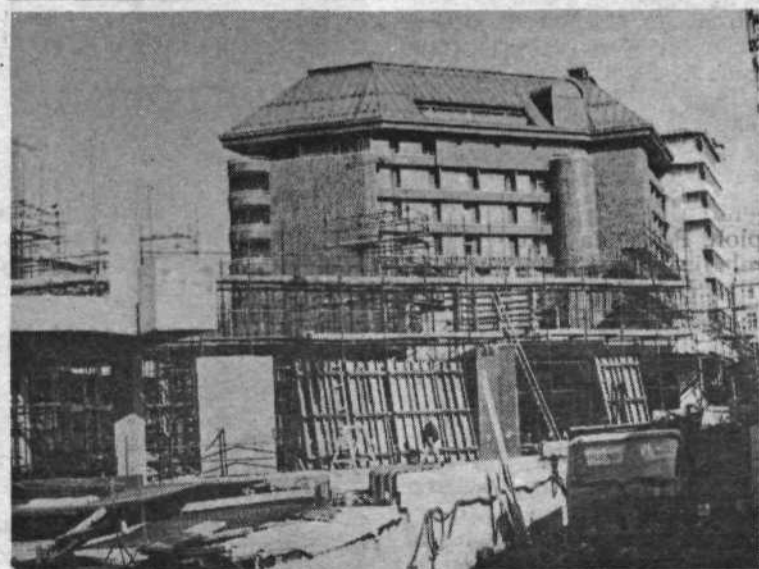
Gradbišče na Kraigherjevi ploščadi med Metalko, Holiday Innom in Šestico je spet oživele. Gradbinci iz Gradisa postavljajo mogočen stanovanjsko-poslovno-trgovski objekt, ki bo po obsegu tak kot sosednja Metalka. Zgrajen mora biti do konca prihodnjega leta. Poleg številnih manjših lokalov bo tudi imel specializirane prodajalne čevljev, blagovni hiši Tkanine in Modne hiše, poslovne prostore Gradisa in Stanovanjsko-komunalne banke. Financira ga 36 investitorjev.
