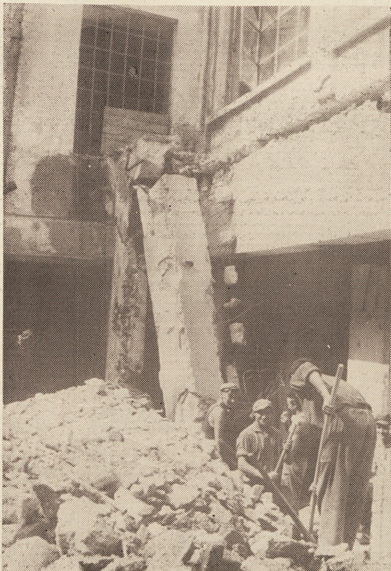
Slika iz Skopja, ne — delavci pri rušenju starega poslopja v tovarni dokumentnega papirja v Radečah
