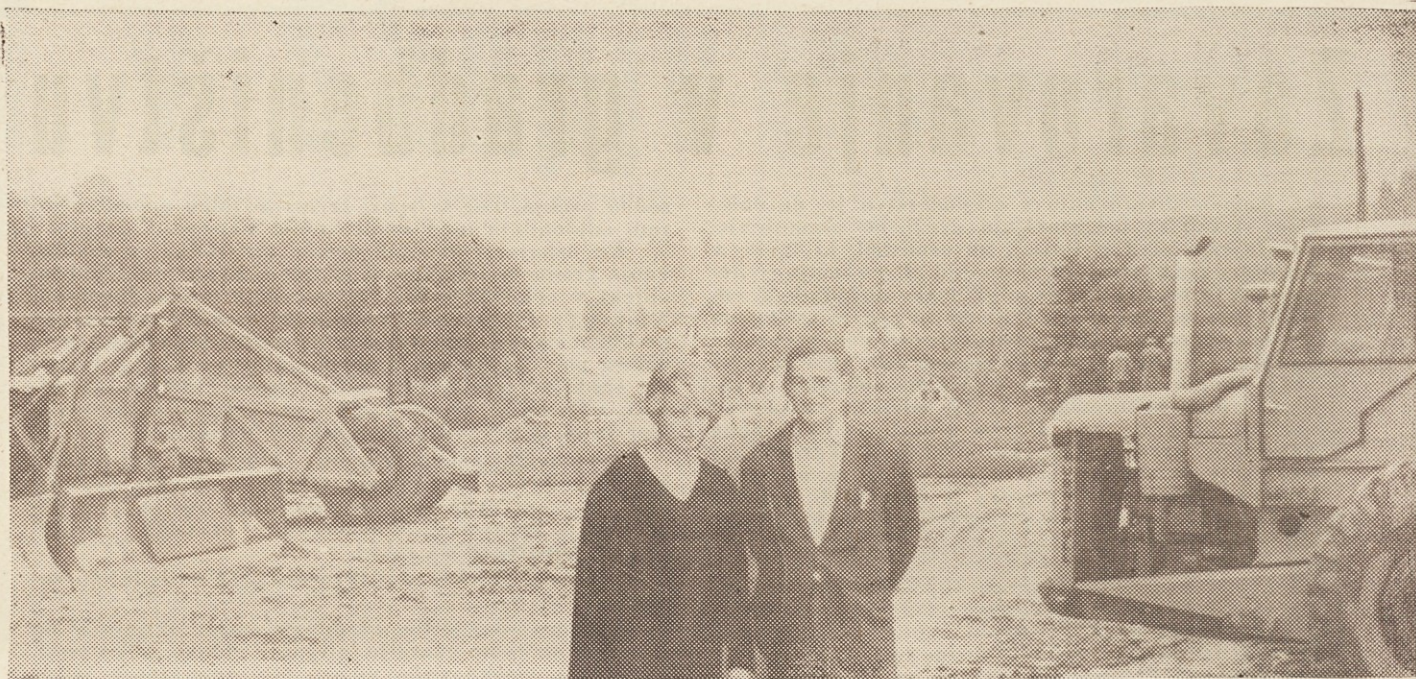
Mehanizacija je stebler gradbeništva, je dejal gradbeni delo vodja Albin Mavser. V sredini tehničarka Majda Komljanec in delovodja Albin Mavser
