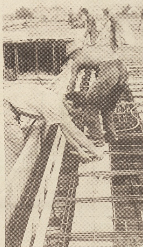
Polaganje armature na upravni stavbi toplarne v Ljubljani
