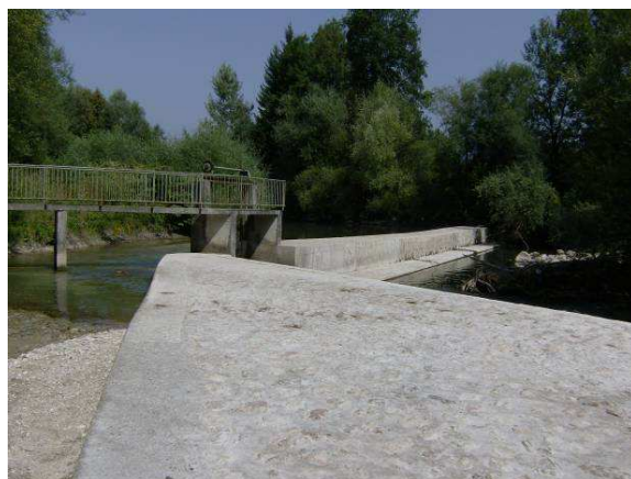
Slika 3 - Preliv Homškega jez z zapornico za talni izpust na sredini v času nizkih vodostajev dne 21. 8. 2009 (levo) in zapornica, ki regulira količino odvzete vode za mlinščico (desno) (foto: Bogataj, 2009).
