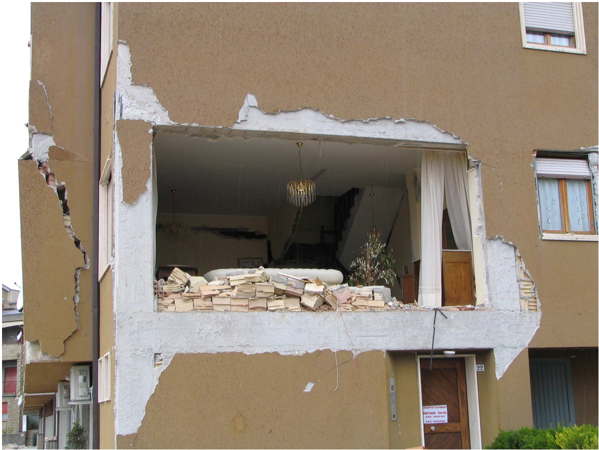
Slika 8. V L'Aquili so bili močno poškodovani tudi novejši stanovanjski objekti. Večinoma so bili poškodovani fasadni elementi armirano betonskih okvirji s polnili izven osi okvira (Foto: M.Godec).
