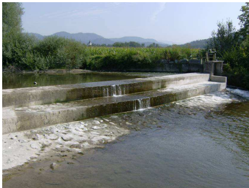
Slika 2 - Radomeljski jez z levoobrežnim odvzemom z zapornicami in talnim izpustom v času nizkega vodostaja (foto: Bogataj, 28. 8. 2009)
