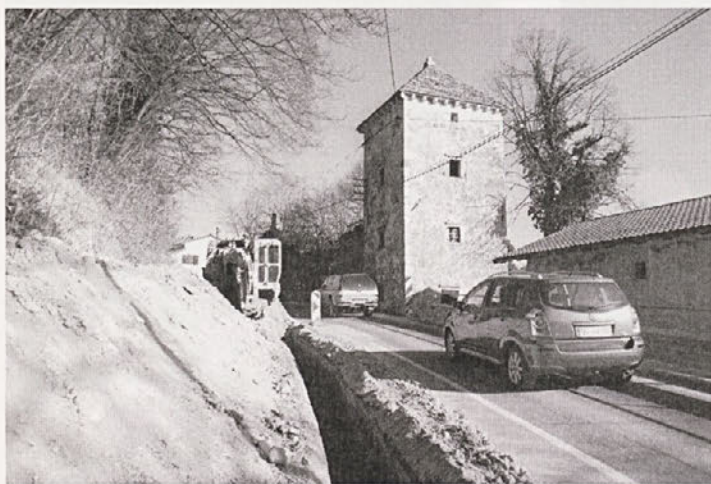
Izgradnja vodovoda na Avžlak. Foto: Luka Bizjak
