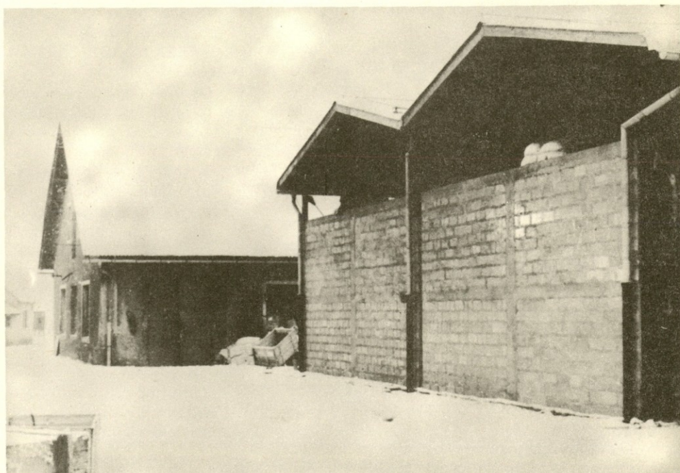
Med dvema starima objektoma v Bohovi, kjer imamo tekstilni obrat, je zrasla nova dvodelna nadstrešnica za skladiščenje tekstilnih izdelkov in odpadkov
