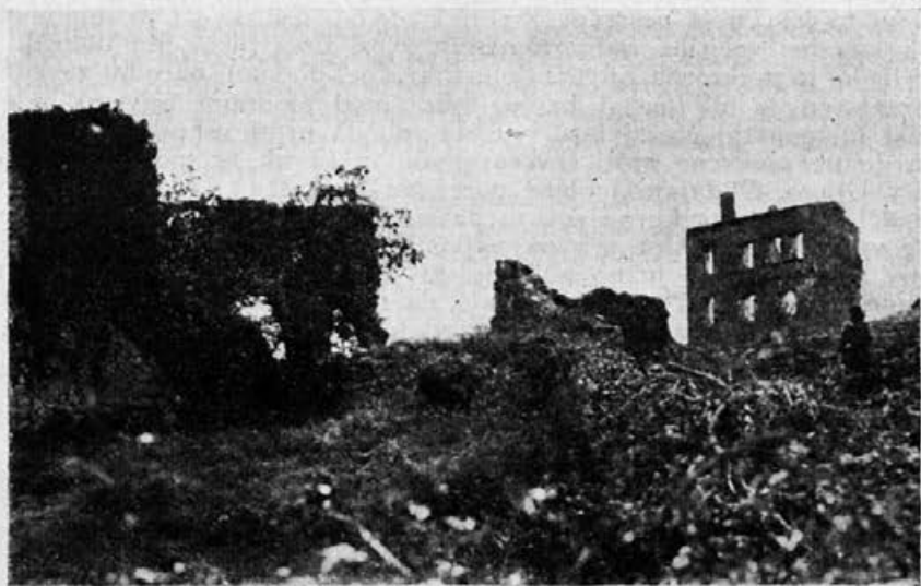
Ruševine kule Rizvanbegovića na Pješevcu kod Stoca. Snimio Hajrudin Ćurić
