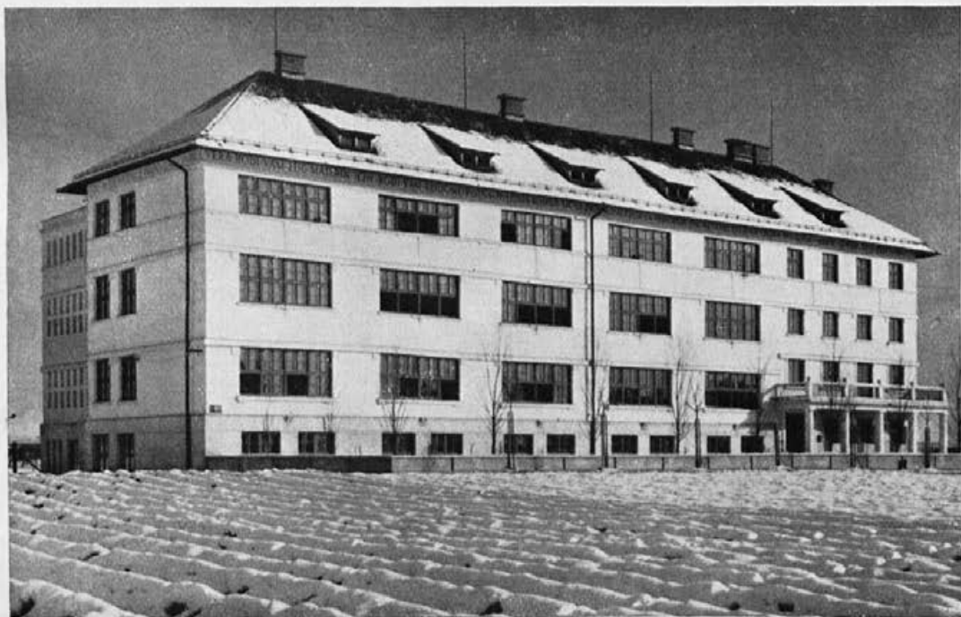
Zahodno pročelje Façade de l'ouest
