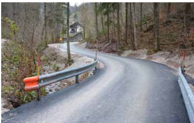
Asfaltirali so okrog 300 metrov makadamskega odseka ceste v naselju Setnica. / Foto: arhiv Občine Medvode
