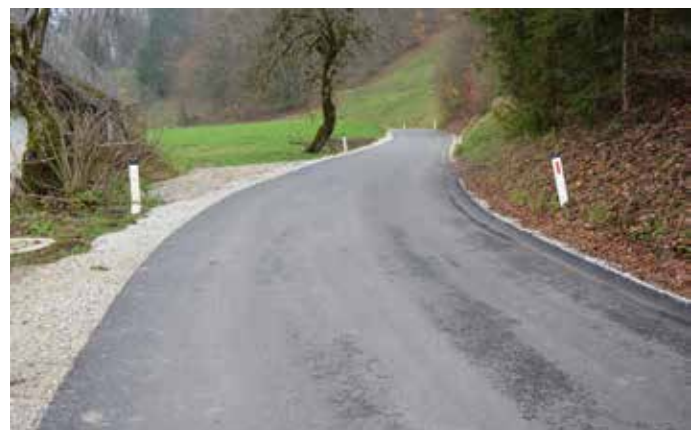
Obnovljen je tudi odsek ceste na Golem Brdu. / Foto: arhiv Občine Medvode
