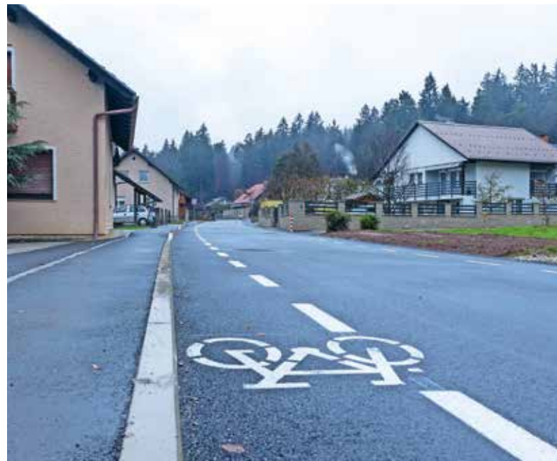
V Žlebeh je bila izvedena rekonstrukcija ceste v dolžini dobrega kilometra. / Foto: Peter Košenina
