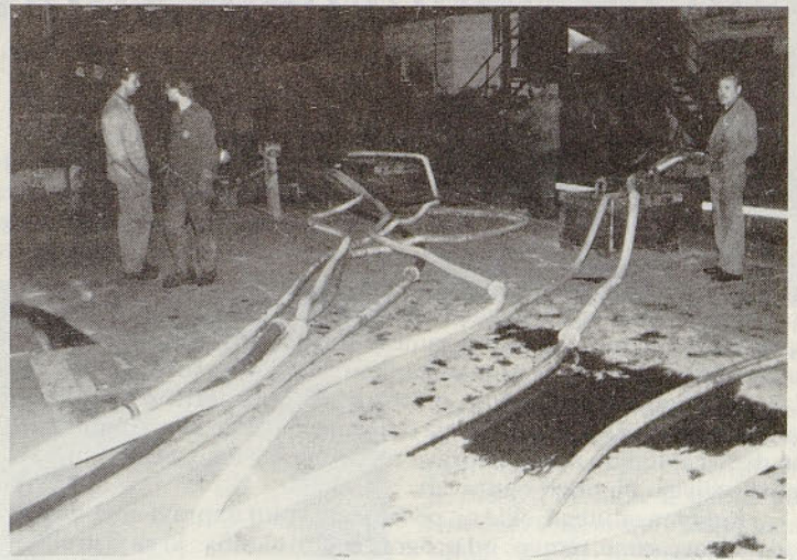
Jeklenih kač smo v valjarni navajeni! Takšnih gasilskih cevi in motornih črpalk se je pa težko navaditi.
