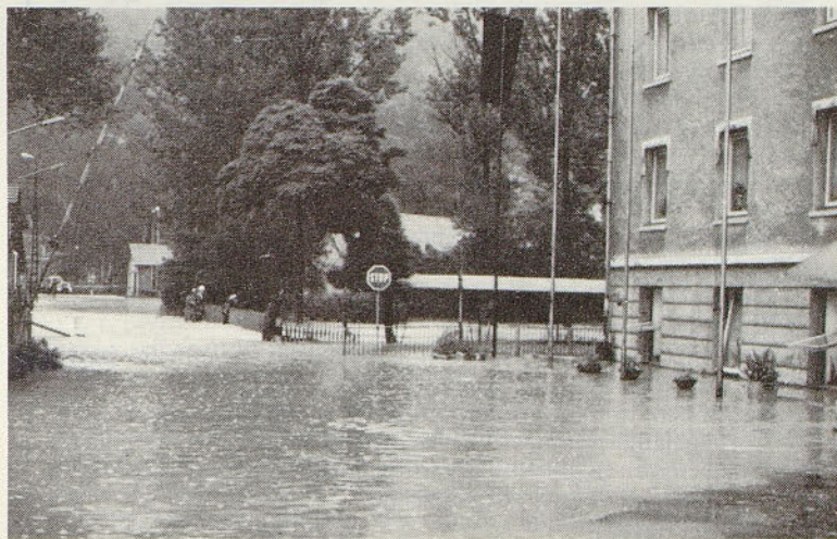
Narasla voda, ki je zalila pritličje upravne zgradbe
