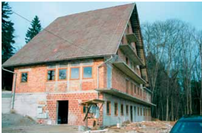
Brdo pri Lukovici. Začela se je vnovična graditev ČIC-a.
