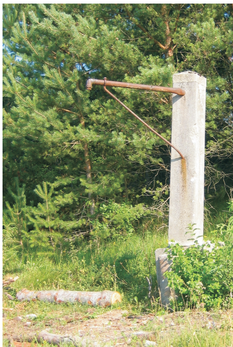
Slika 3: Pipa z vodo. Vodne pipe so postavili ob cestah in so bile namenjene za polnjenje vojaških avtocestern (Foto: M. Čuček).
