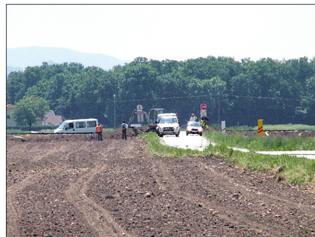
Dela na železniški progi v območju občin Dornava in Gorišnica so v polnem teku.
