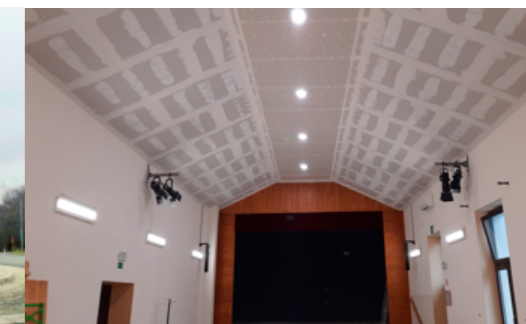
Sanacija kulturne dvorane Ivanjkoč.
