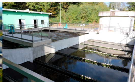
Nadgradnja in rekonstrukcija čistilne naprave Ormož.
