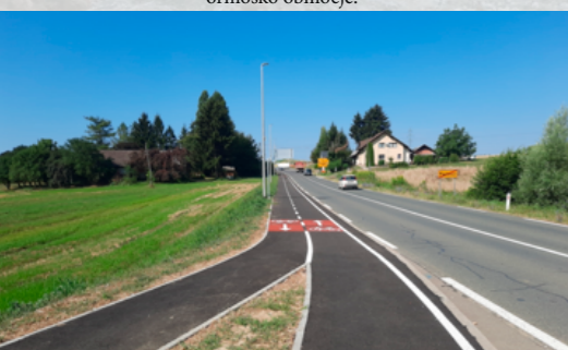
Izgradnja steze za kolesarje Libanja-Pavlovci-Ormož.
