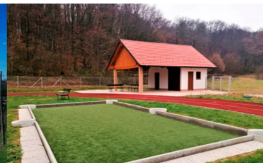
Izgradnja objekta na igrišču Miklavž.
