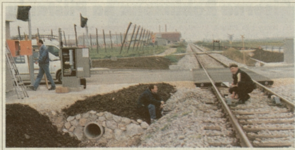
Delavci podjetja Amile Iskra iz Kranja pri montaži zapornic.
