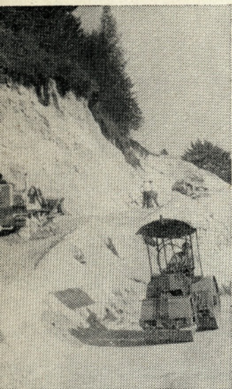
Cesta zahteva obsežna zemeljska dela
