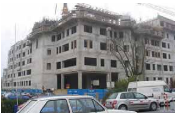
d. Gradnja NPK – bodoči vhod.
