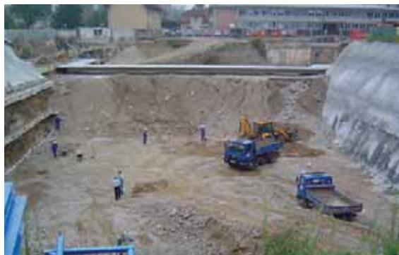
b. Gradbena jama za NPK leta 2003.
