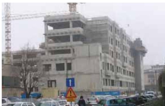
č. Gradnja NPK novembra 2005.
