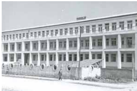
b. Stavba ob vselitvi leta 1952.
